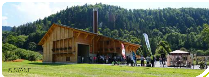
Chaufferie biomasse d'Abondance (74)
