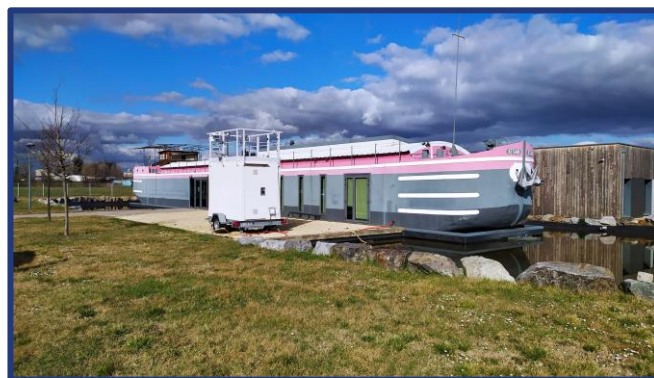
Figure 2 Photo du site de mesure Maison de Projet INSPIRA
