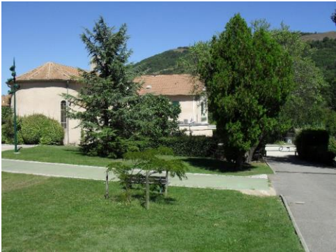
La station de mesure est installée dans la Mairie, le prélèvement est réalisé en toiture
