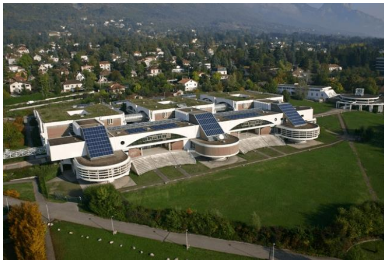
FIGURE 2 : VUE AERIENNE DU LYCEE DU GRESIVAUDAN
