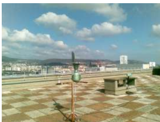
Capteur de pollens du site de Clermont-Ferrand (Hôpital CHU Gabriel MONTPIED - 58, Rue Montalembert - CLERMONT-FERRAND) Prélèvement à une hauteur de 30 m du sol
