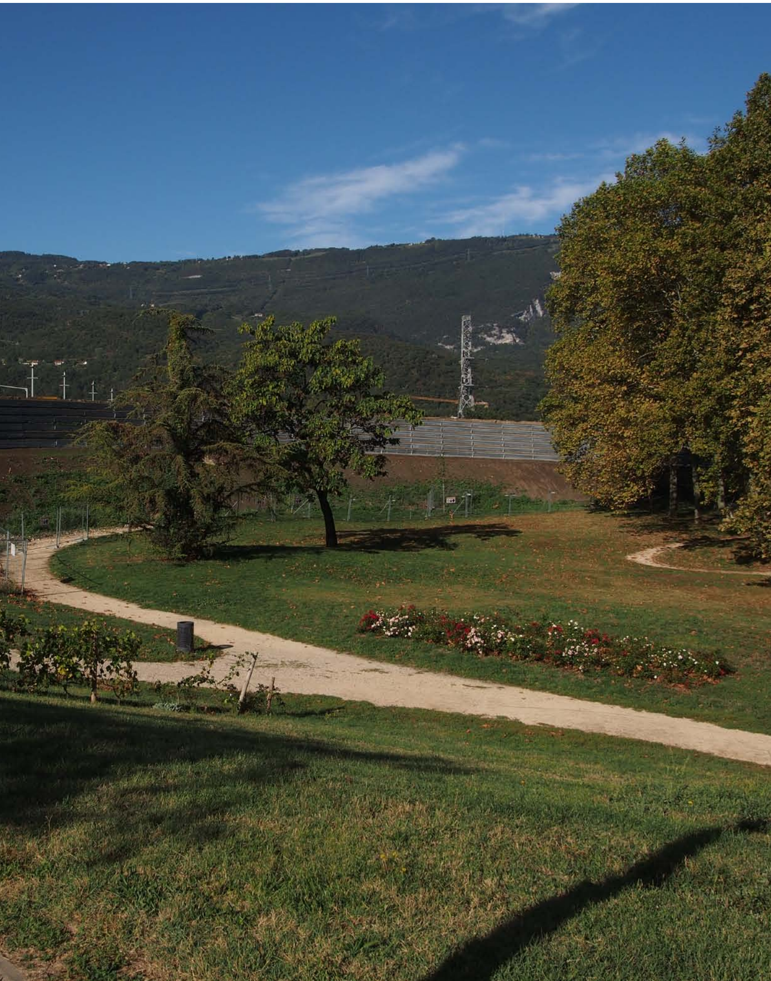
Chantier de l'A 480 avec la construction d'un mur anti-bruit Naturawall en terre végétalisé
