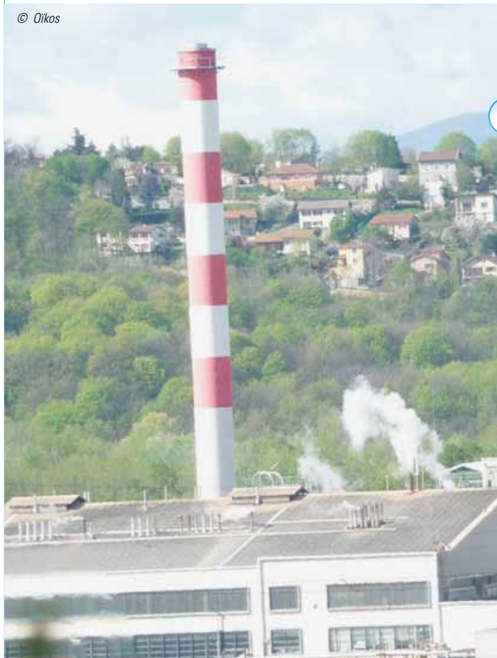
Cheminée d'usine vue de Saint-Fons
