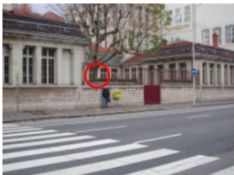
Site «Lafayette» (vue extérieure)
