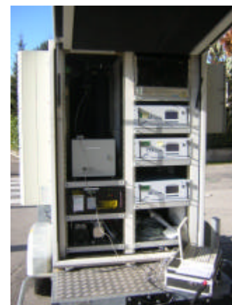
Intérieur de la remorque laboratoire
