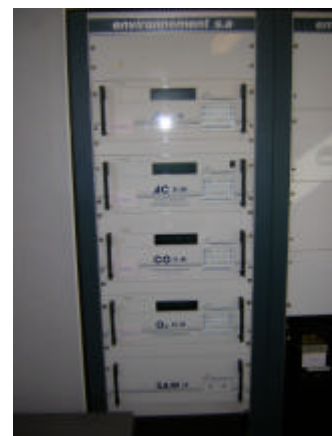
Intérieur du camion laboratoire
