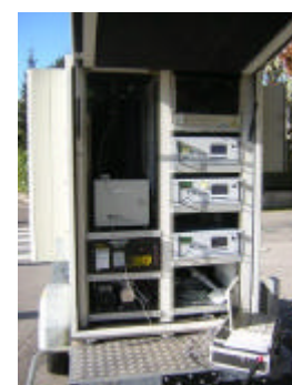
Intérieur de la remorque laboratoire
