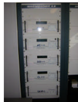
Intérieur du camion laboratoire
