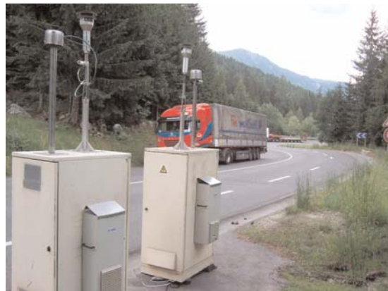
Accès au tunnel du Mont Blanc
