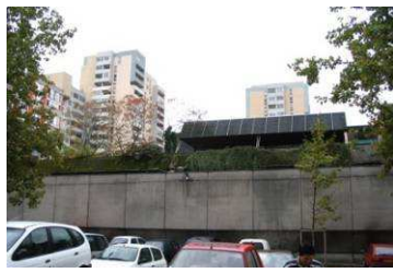
Figure 8 : L'école de La Rampe située sur un parking "silo".
