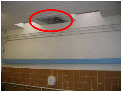
Photo 7 : extraction d'air dans les toilettes
