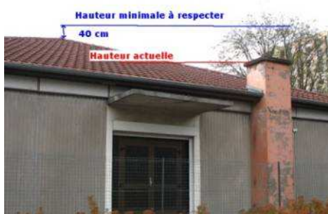
Figure 9 : Rehaussement de toit d'un bâtiment.
