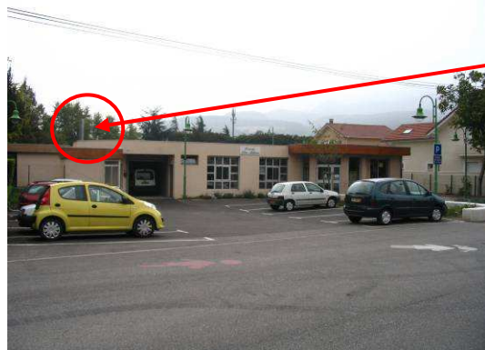
Photo 3 : Vue extérieure de la crèche
