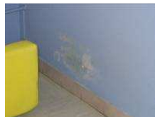
Photo 4 : traces d'humidité
