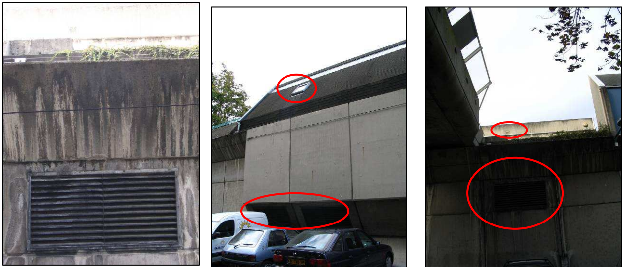
Photos 4, 5 et 6 : Vues des extractions d'air du parking.
