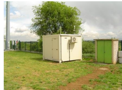
STATION DE MESURE DE LA QUALITE DE L'AIR « SAINT EXUPERY »
