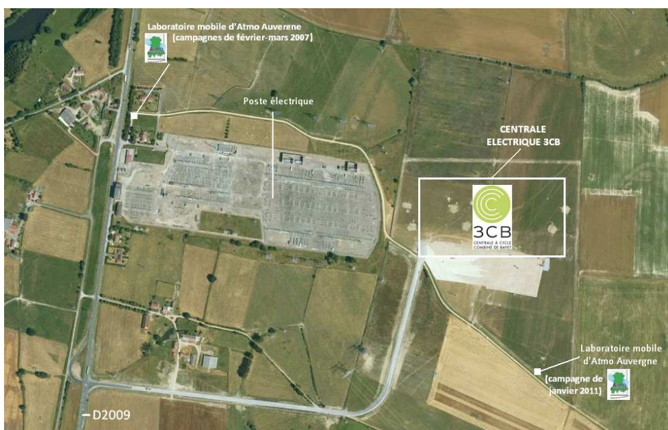
Centrale électrique de Bayet et situations du laboratoire mobile de mesure d'Atmo Auvergne en février-mars 2007 et janvier 2011
