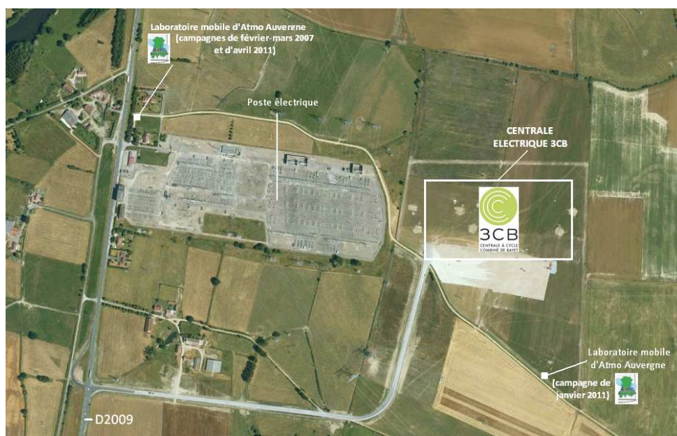
Centrale électrique de Bayet et situations du laboratoire mobile de mesure d'Atmo Auvergne en février-mars 2007, janvier 2011 et avril 2011
