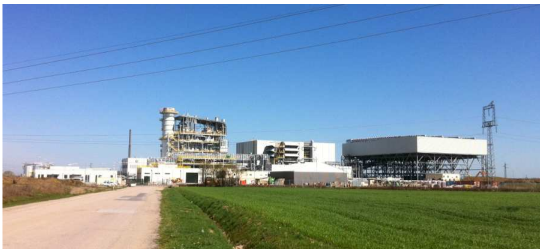
Centrale électrique de Bayet (avril 2011)
