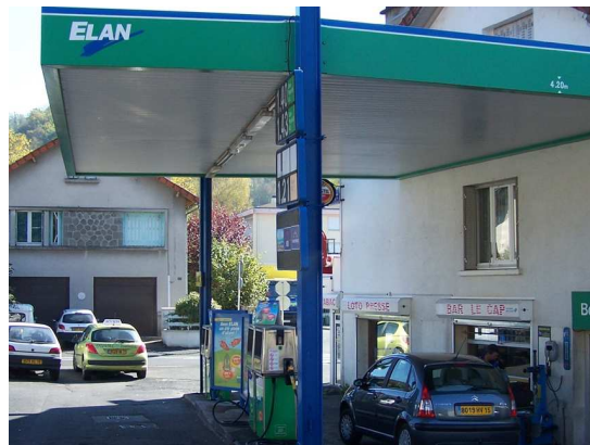
site 10 - Aurillac ELAN - 15 boulevard Jean Jaurès
