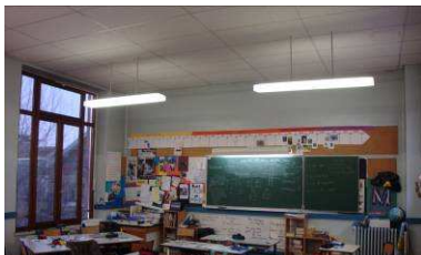
Photo 18 : Une salle de classe au rez de chaussée.
