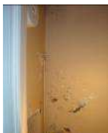
Figure 8 : Traces d'humidité
