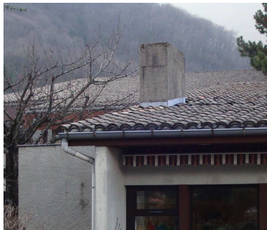
Photo 6 : La cheminée de la chaufferie.
