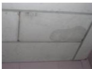
Figure 12 : Humidité sur un plafond.
