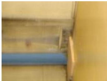
Figure 9: Bouches d'entrée d'air neuf obturées suite à la mise en place d'un cloison.
