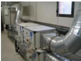
Figure 10 : Installation VMC double flux.
