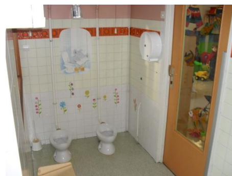
Photo 3 : Les sanitaires donnent directement dans le couloir.
