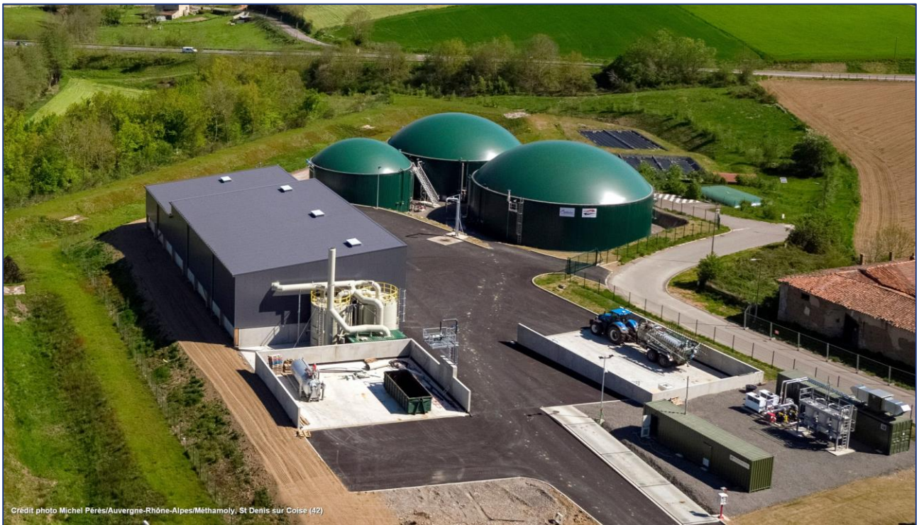
Figure 23 : Unité de méthanisation agricole Méthamoly (Saint-Denis-sur-Coise)
