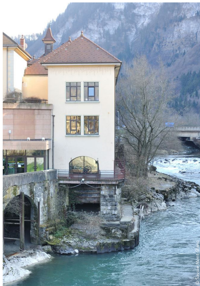
Vue de l'ancienne fabrique d'horlogerie de Cluses.
