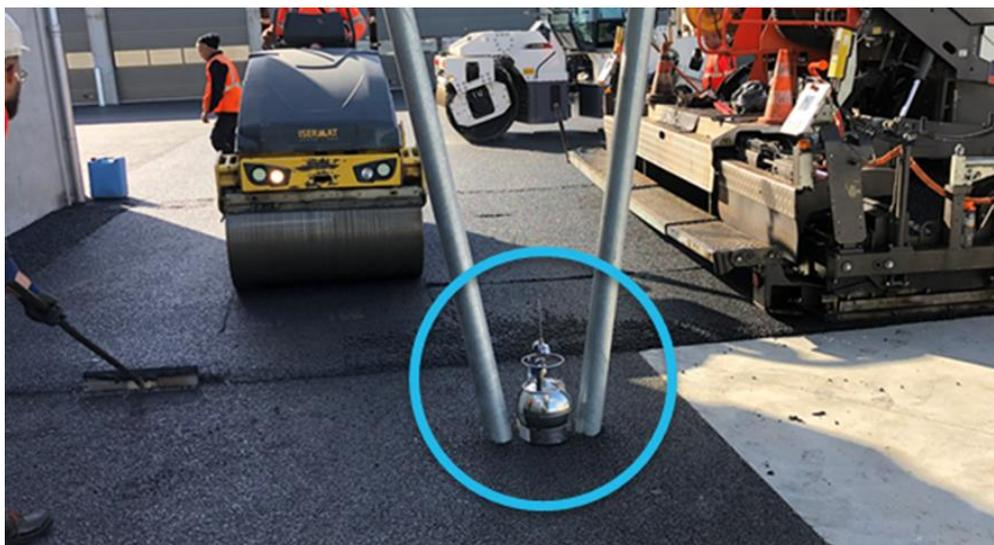
Figure 8 : Prélèvement effectué par un canister lors d'un chantier de mise en œuvre d'enrobés tièdes
