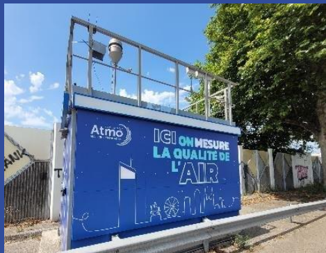
Habillage de la station de mesure Lyon Périphérique
