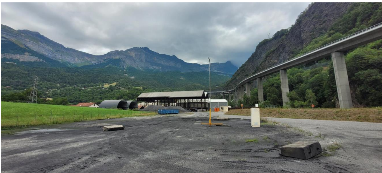
Figure 3 : Mât météo dans l'enceinte de SGL Carbon
