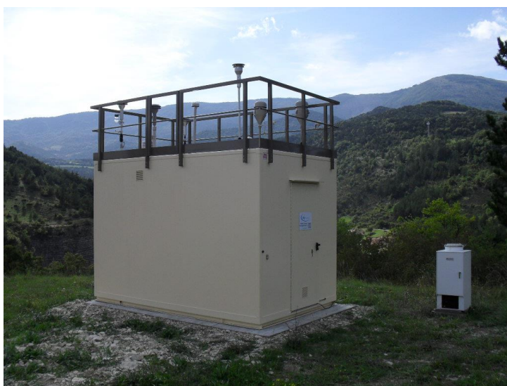
Station de mesure fixe Drôme Rurale Sud (DRS) à Saint-Nazaire-le-Désert (Source des photos : Atmo Auvergne Rhône-Alpes)
