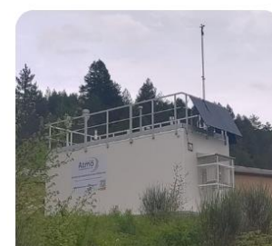
Station fixe Drôme Rurale Sud à Saint-Nazaire-le-Désert
